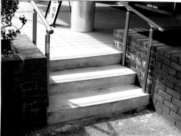
新設された駐車場から玄関への階段
