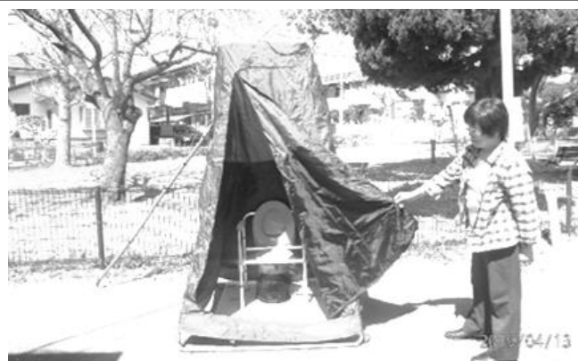
マンホールトイレ設置状況(会事務所脇)
